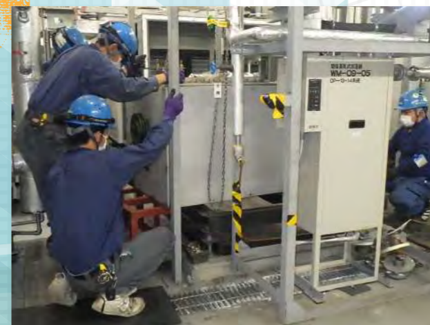
空調機の取り外し・設置施工風景
