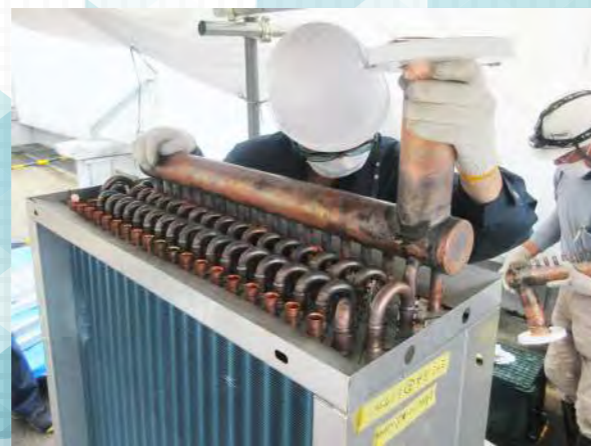
取り付け仕上げ加工
