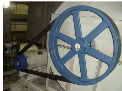
プーリー交換後
