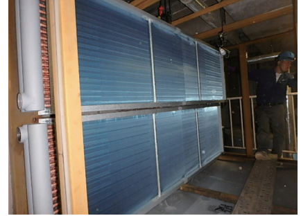
コイル入替完了
