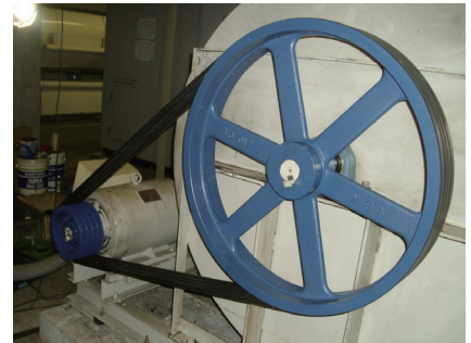
プーリー交換後
